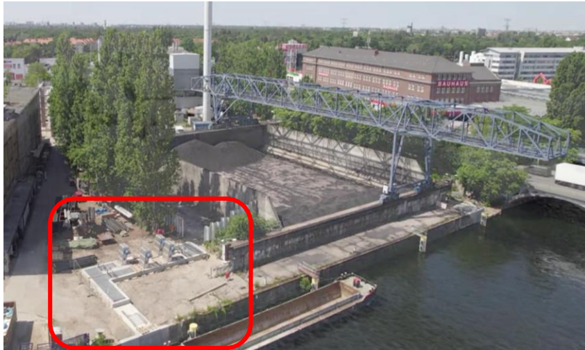
Standort mit Entnahmebauwerk
