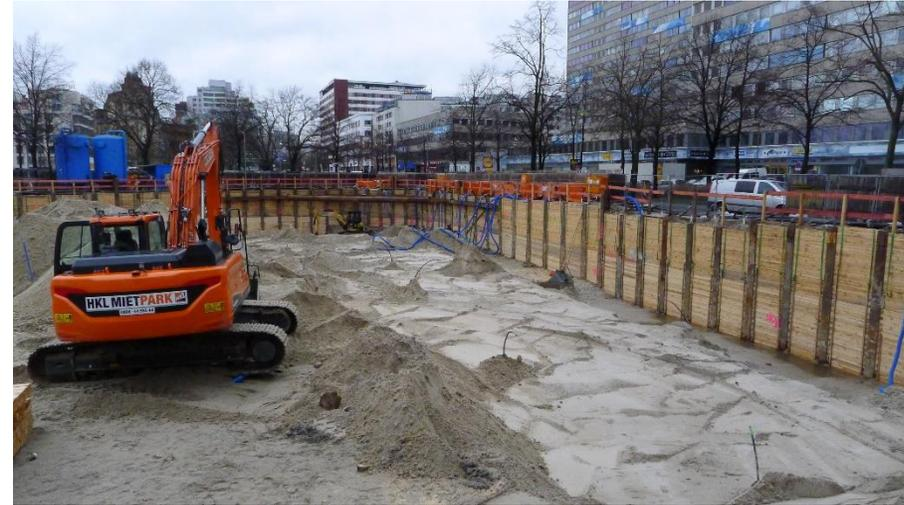
Ausheben der Baugrube
