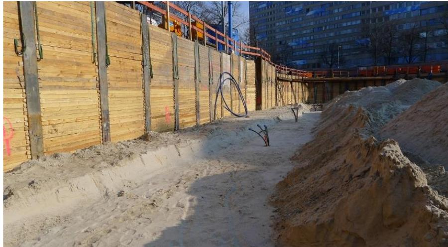
Leitungsraben mit Erdwärmesondenköpfen
