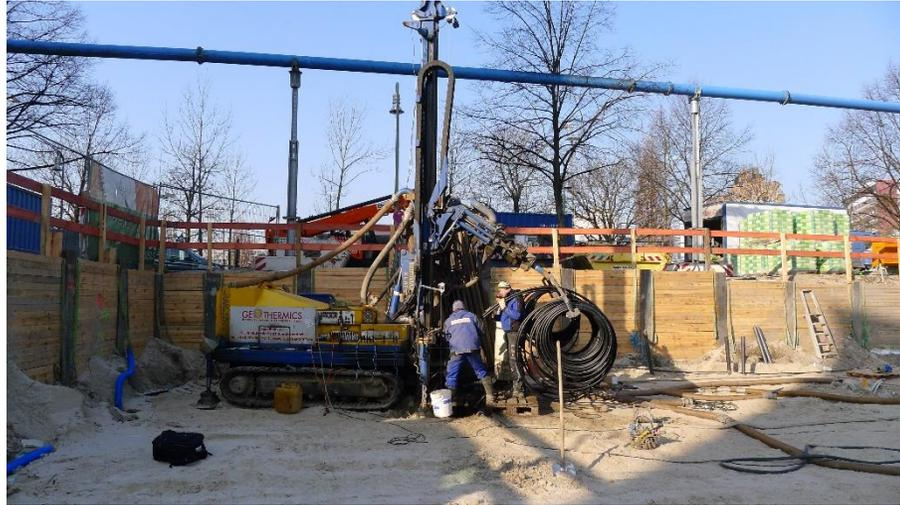
Sondenbohrung u. - Einbau von der Oberfläche der Voraushubsohle
