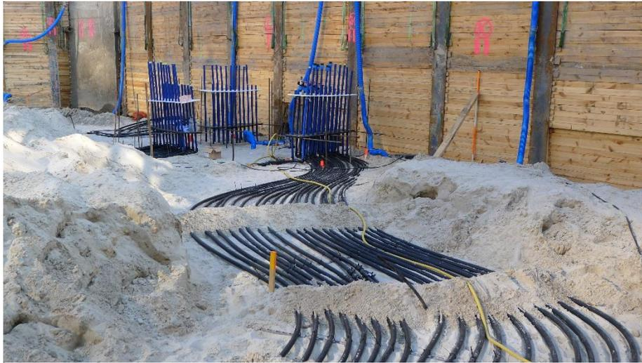
Verlegung der Anbindeleitungen, Druck- und Durchflussprüfung
